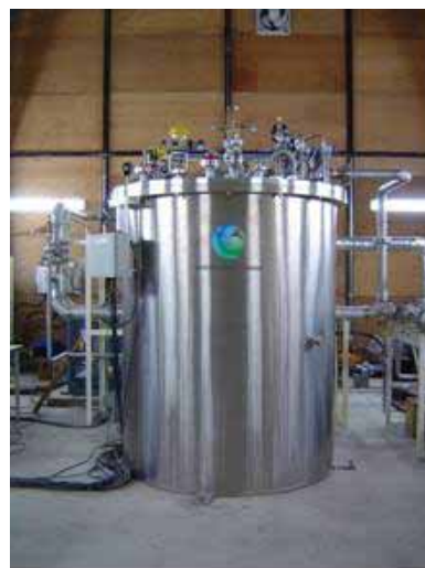
図2 冷凍機 Cold Box
