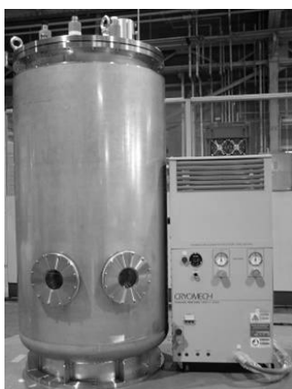
図1 三相分の限流コイル(左)、サブクール窒素冷却容器と冷凍機圧縮機(右)
