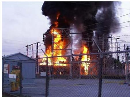
図5 従来型変圧器の火災事故
