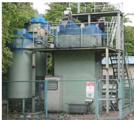
図1. 磁化活性汚泥法パイロットプラント—50 人分の下水を余剰汚泥を発生させずに処理できる。
