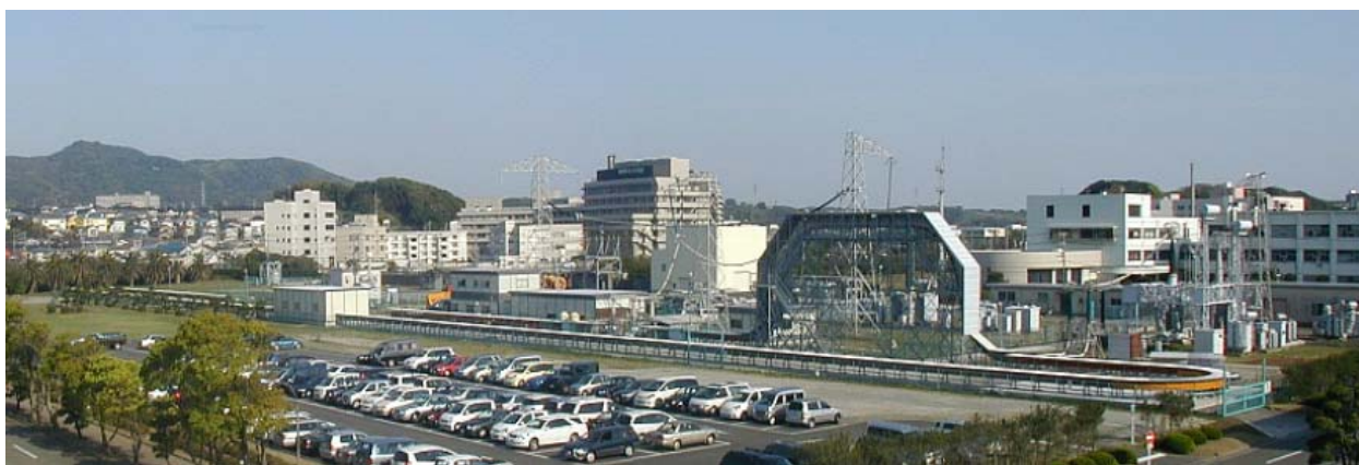
古河電工と電中研が冷却を含めて検証した 500 m 長超電導ケーブルの試験状況
