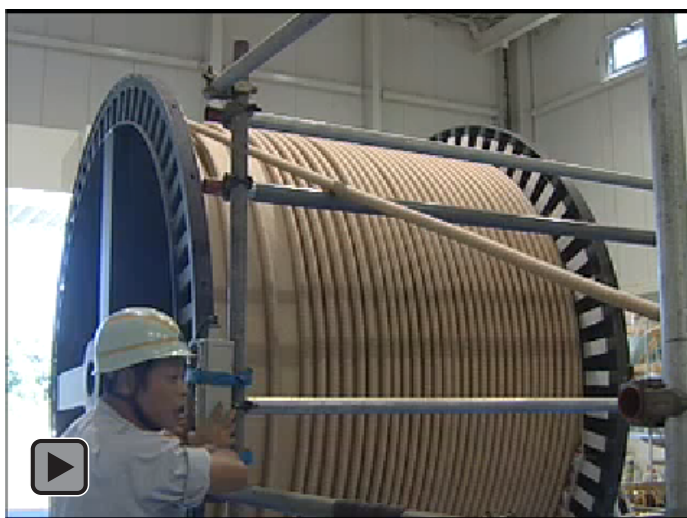
ケーブル引き込み作業（動画）
