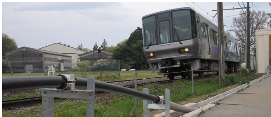
超電導ケーブルによる車両の走行試験
