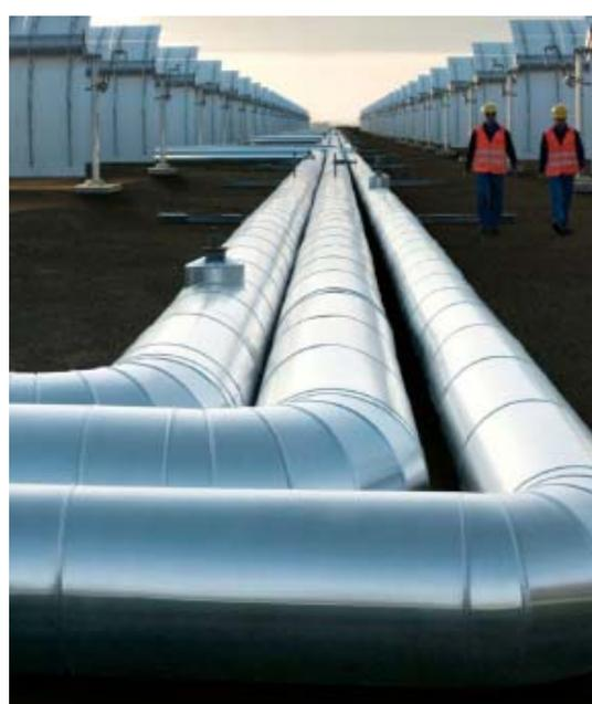
図5 Siemens 社太陽熱プラントの熱媒配管<sup>5)</sup>
