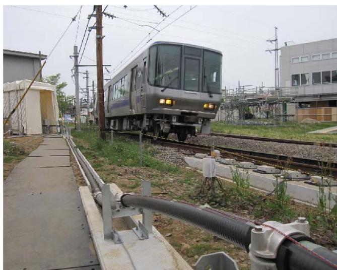
図1 鉄道路線に導入した31 m超電導ケーブル
