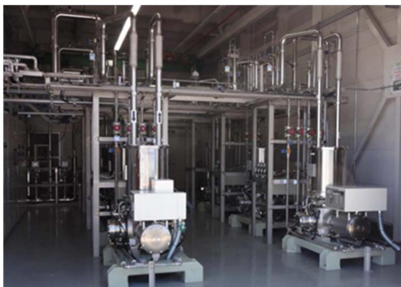
図1 高温超電導ケーブル実証試験用冷却システム
