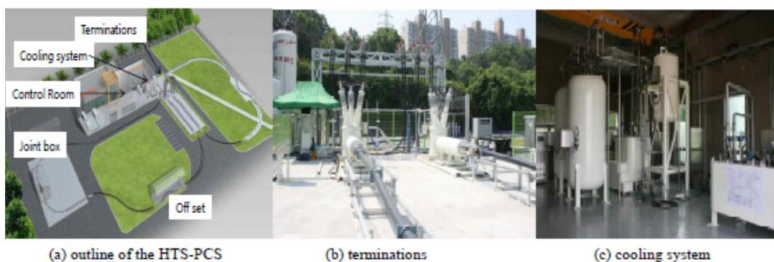
図 4-5 韓国電力利川変電所 HTS ケーブルシステム (韓国電力 Yang 氏提供)
