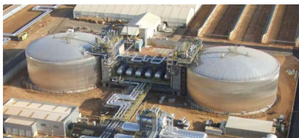
図 1 300 MWh ものエネルギーを 23 m 直径のタンクで貯める
