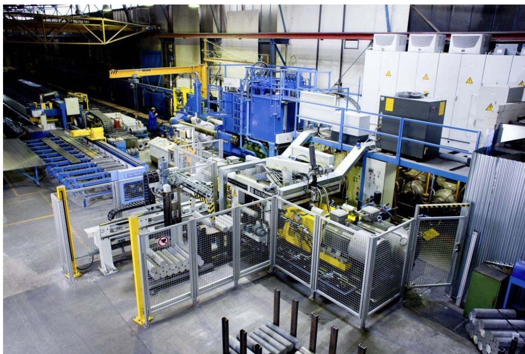
図 2 稼働中の超電導炉。超電導を意識することなく連続稼働している。
