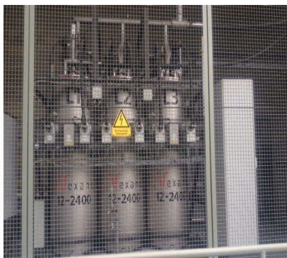
超電導限流器（YBCO 系線材を使用）
