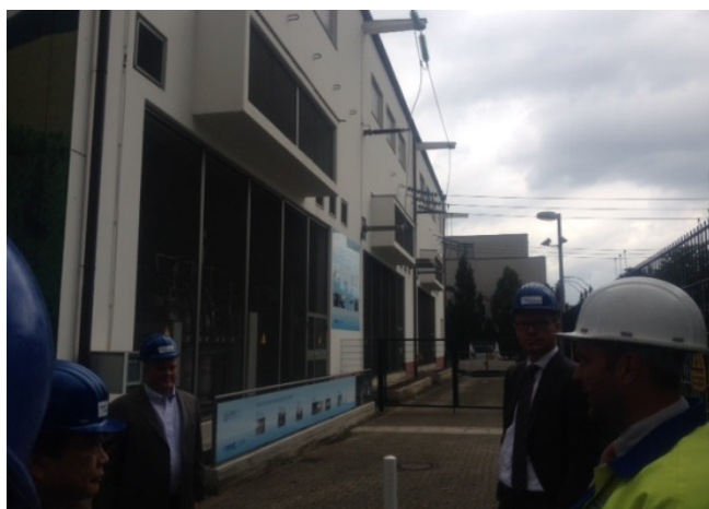
Ampacity 高温超電導設備全景（変電所内）
