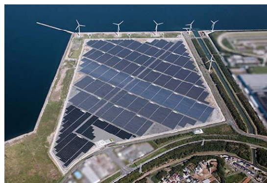
図 1 たはらソーラー・ウインド発電所(愛知県田原市) [1] 。風力発電(6 MW)と太陽光発電(50 MW)による国内最大規模のハイブリッド発電所。
